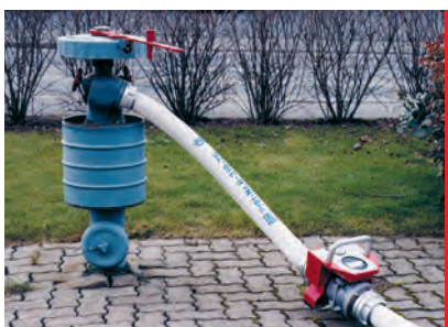
• Durchflussmengenmessung am Überflurhydranten.
